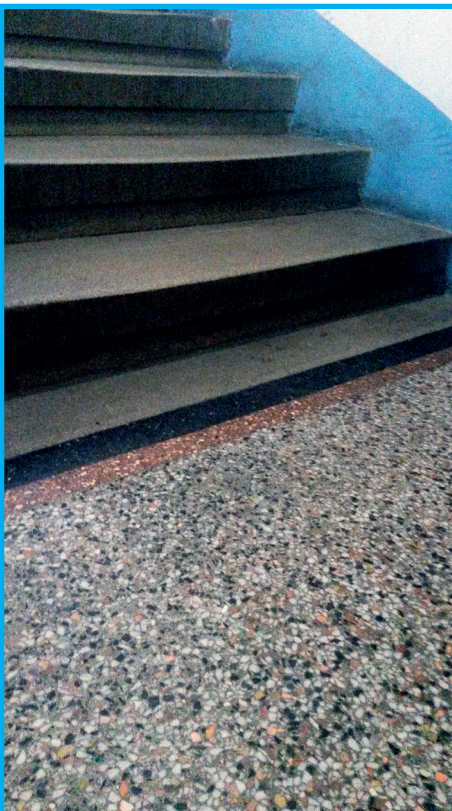
Boden im Stiegenhaus
